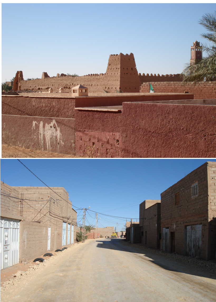
photo n°5: Une kasba en voie de dégradation (Plus haut) et une nouvelle extension réalisée par des constructions en parpaing (en bas), ksar de Tilouline en 2008
