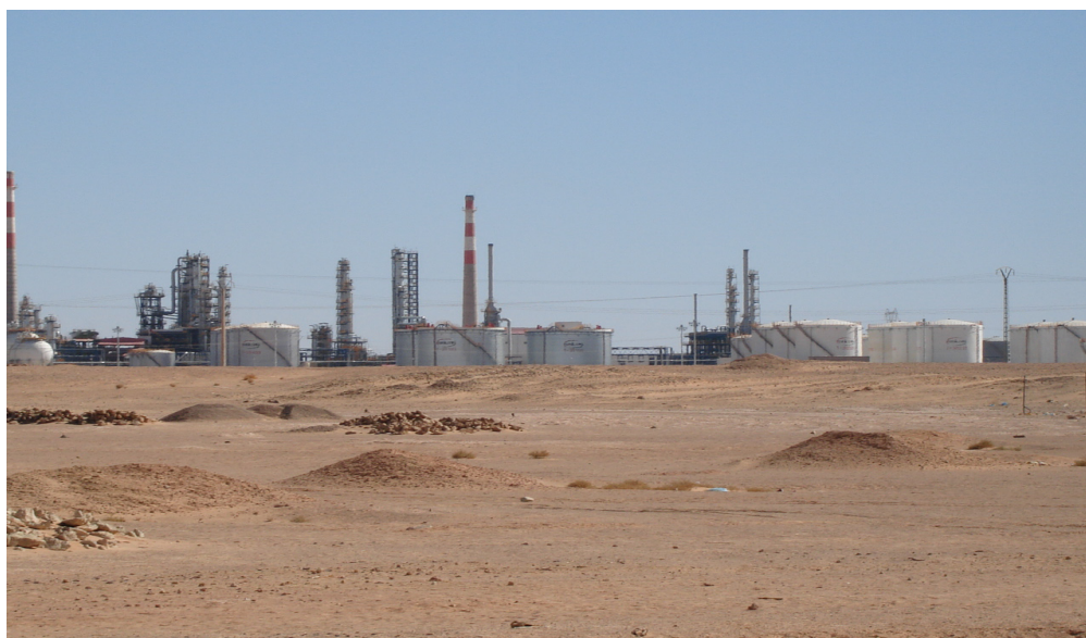
Photo n°31 : La raffinerie de Sbaa, Adrar, 2008
