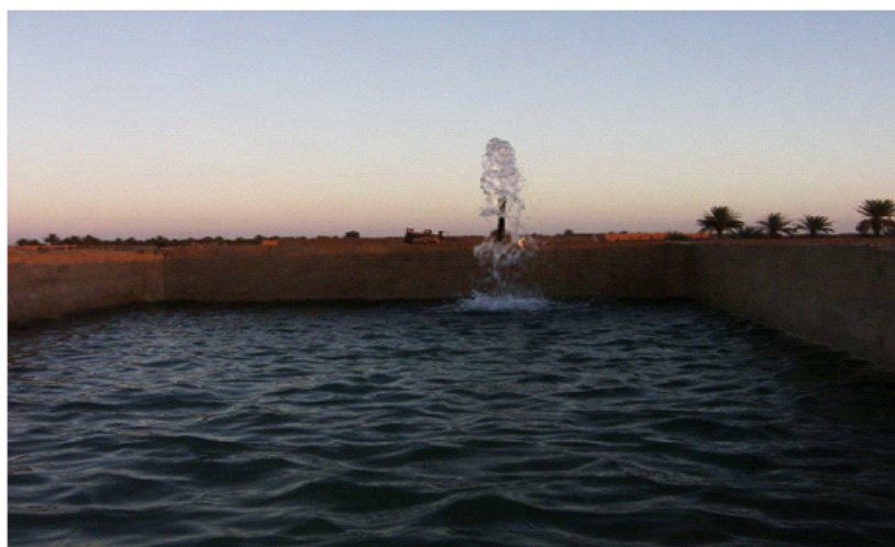
Photo n°22 : Bassin d'irrigation alimenté par un puits qui débite 10 l/s à Ouaina, Touat, 2005
