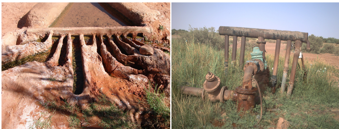
Photo n° 23: Partage égalitaire de l'eau de forage par répartiteur métallique, périmètre des Moudjahidine à In Salah et un partage de l'eau de foggara par un répartiteur en pierre à Aoulef, conçu en fonction des droits de possession, 2008
