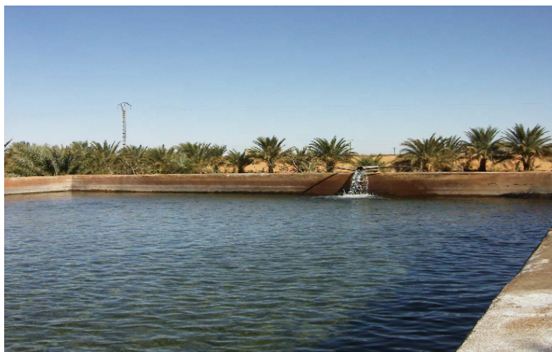
Photo n°13 : Bassin d'irrigation de 100 m 3 construit en ciment et financée par le PNDA, Sali, 2005
