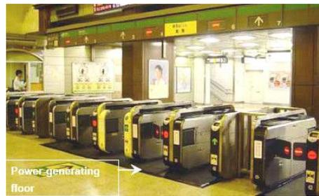
FIG. 1.8 – Récupération d'énergie dans une station de métro à Tokyo [6]
