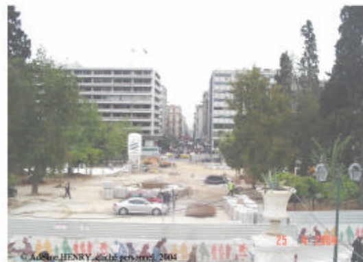
© Adeline HENRY, cliché personnel, 2004 Les travaux (2004)
