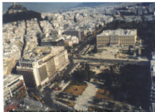
Département des transports, en collaboration avec le Pavillon de l'Ancêtre, Paris (1999) Place Syntagma, avant les travaux (1999)
