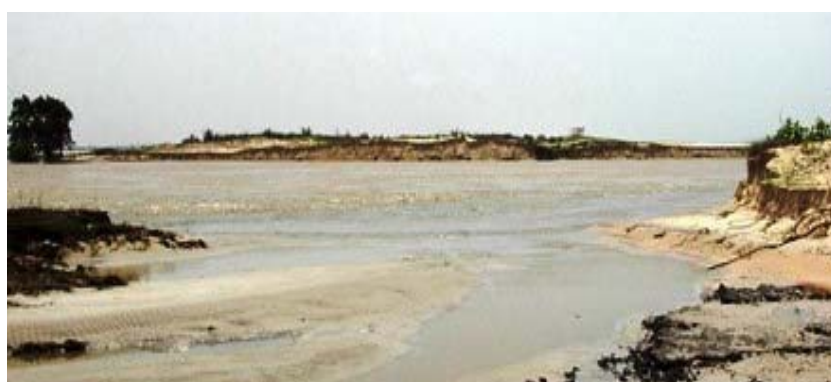
FIG. B.2: La brèche deux jours après l'ouverture.
